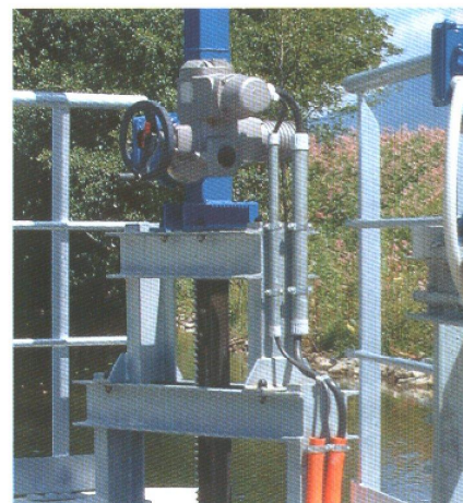
jednoduchý zvedák stavidel 100 kN s regulovaným pohonem
