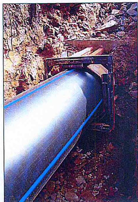
zontálního vrtání (HDD) a dodnes se svými pěti stroji patří k nejvýznamnějším firmám v oboru. U opravy přivaděče Zborovská šlo o použití stroje pro řízené horizontální vrtání pro technologii reliningu, což není
