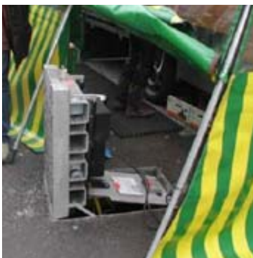
Příklad z praxe - po připojení kabelů se rozvaděč opět uzavře
