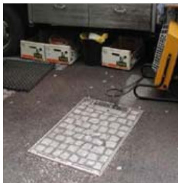
Příklad z praxe - po připojení kabelů se rozvaděč opět uzavře
